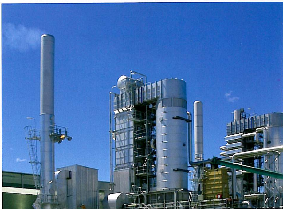
Комбинация из котла с конвекционным термомасляным теплообменником в меандровом исполнении с мощностью 28 MW для обогрева лесопильного завода в Австралии.
