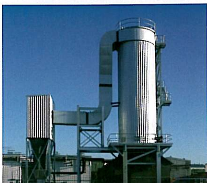
Твердотопливный термомасляный нагреватель в трехходовом исполнении, мощностью 12 MW, Австралия.
