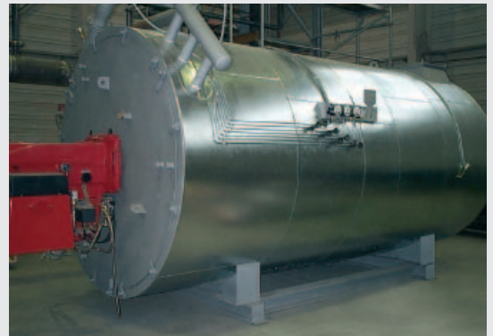
Erdgasbefuener Thermalölerhitzer für die Lebensmittelindustrie mit einer Leistung von 1,6 MW, in Texas, USA
