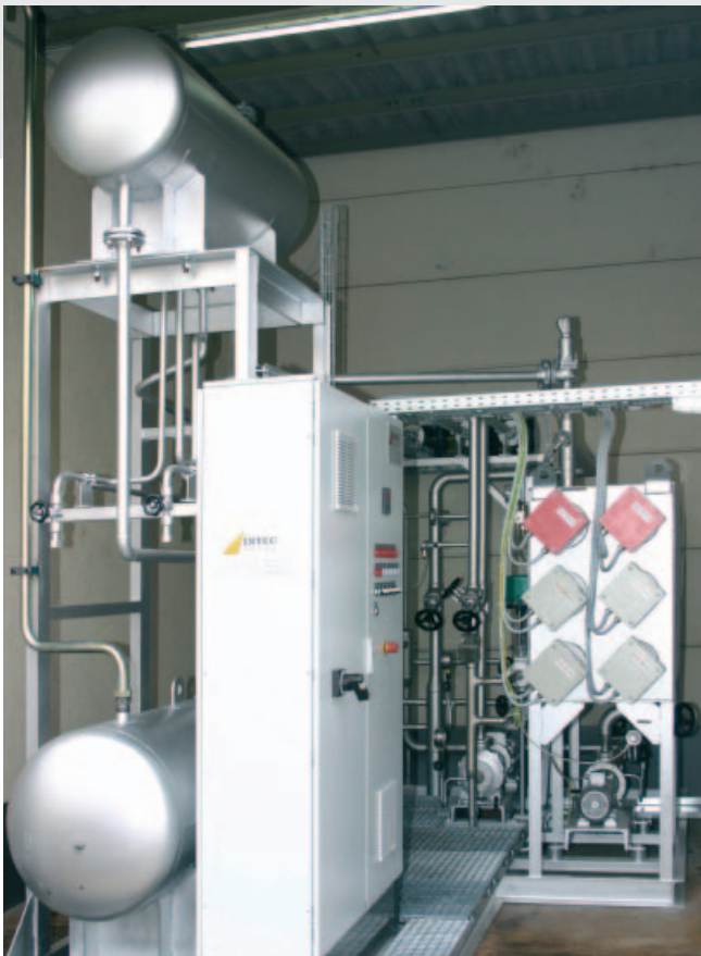
Elektroerhitzer mit einer Leistung von 150 kW mit sechs Heizelementanschlüssen für eine individuelle und exakte Regelung
