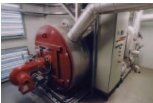
Horizontal aufgestellter Erhitzer für die Lebensmittelindustrie, vormontiert und verkabelt als Kompaktbau
