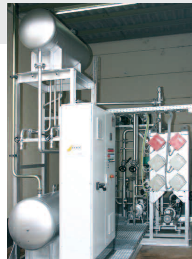
электронагреватель с мощностью 150 кВт, с шестью нагревательными элементами для индивидуальной и точной регулировки
