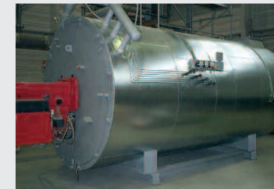
термомасляный нагреватель, сжигающий природный газ, мощностью 1,6 МВт для пищевой промышленности, Texas, USA
