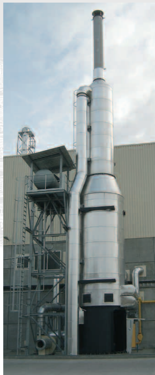
Вертикальный термомасляный нагреватель, на природном газе, мощностью 9,6 MW со встроенным подогревателем воздуха, и далее идущем камином, общая высота 25м, для обогрева ДСП-пресса в Румынии
