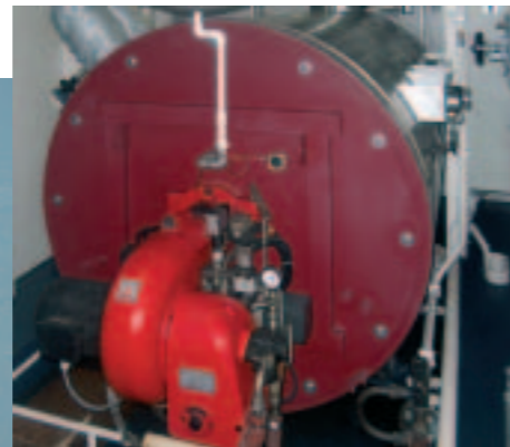
Saugbagger mit Erhitzer 1000 kW und Abhitzekessel 860 kW
