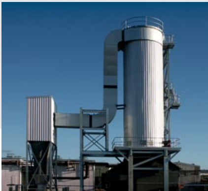
Feststoffbefeuerter Thermalölerhitzer in 3-Zug-Bauweise, Leistung 12 MW, Australien
