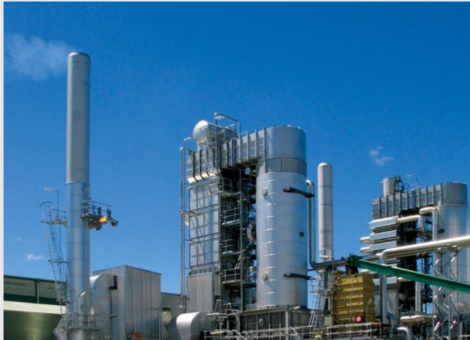
Kombination von Strahlungskessel mit Konvektionswärmeaustauscher in Mäander-Bauweise mit 28 MW Thermalöl-Leistung zur Beheizung eines Sägewerkes in Australien
